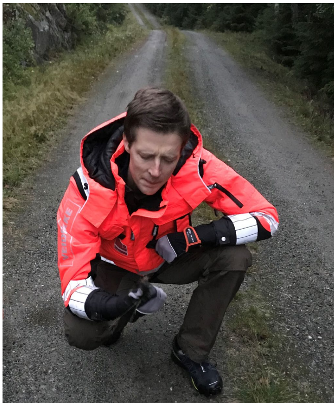
Pukk-inspeksjon, D&V dugnaden på Bråkedalsveien, Øvre Eiker
