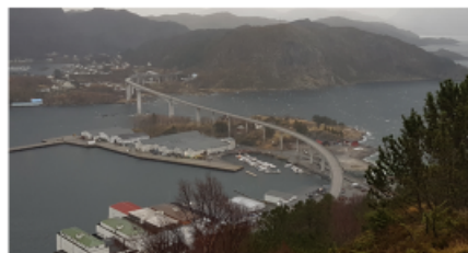
Måløybrua, rv. 15 Vestland. Ferdig rehabilitert 2021 – 100 mill.
