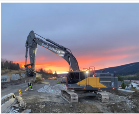
E16 Fagernes – Øylo i Valdres er pilotprosjekt for nytt konsept. Kontrakten med Brødrene Dokken AS har en økonomisk ramme på 500 millioner kroner. Foto: Brødrene Dokken AS
