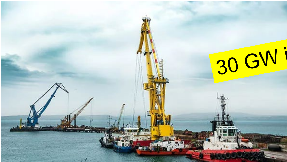
Operasjoner for installasjon og utskiftning
