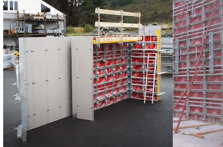
foto: Romarheim kran og forskaling
