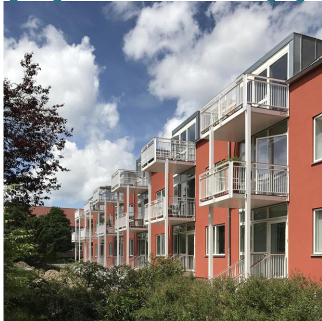
(Energi)reovering Toftebo, Bjerg Arkitektur
