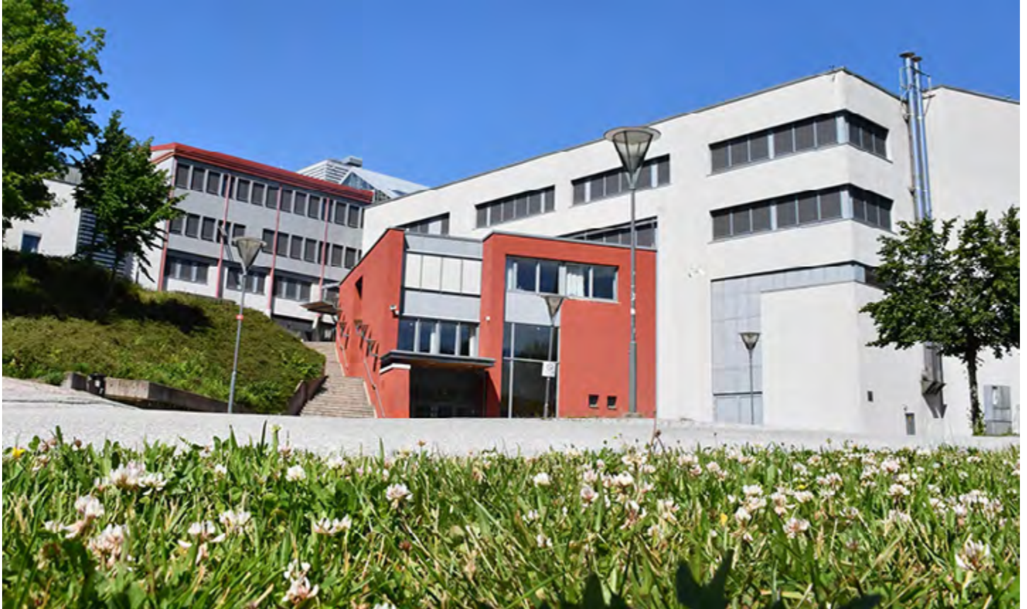
Halden videregående skole. Foto: Østfold fylkeskommune
