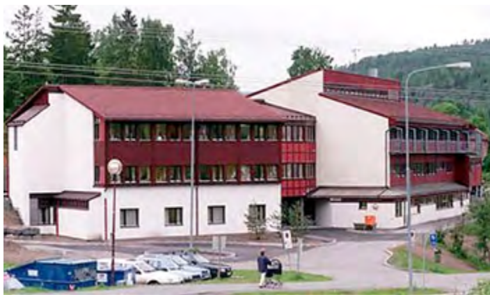
Bærums Verk avlastningsskole.
