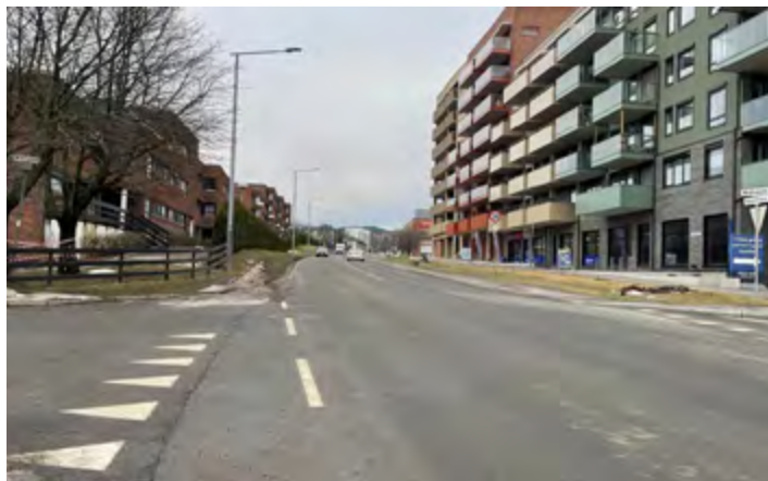
Gateopprusting i Brobekkveien.
