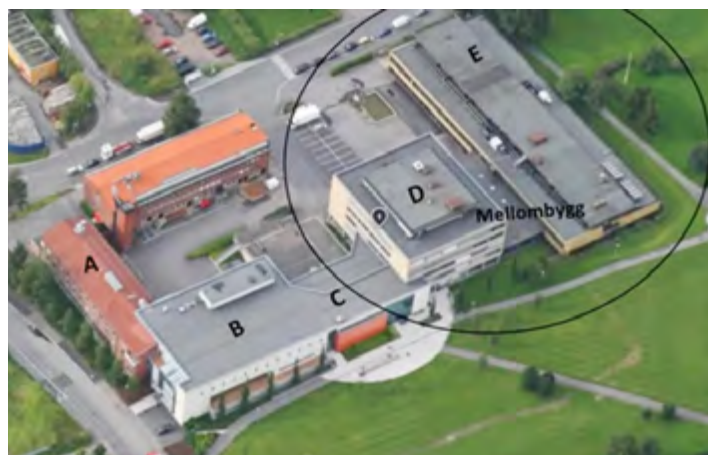
Bygg E skal rives og erstattes med et nytt bygg på Etterstad vgs.
