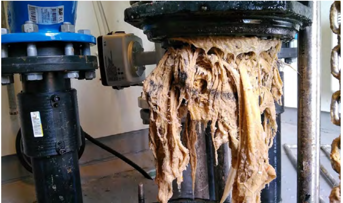
Tre tonn søppel fjernes hvert døgn i Oslos to renseanleggene før vannet kan renses.
