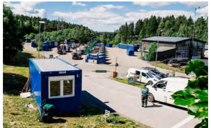
Nåværende Grønmo gjenvinningsstasjon.
